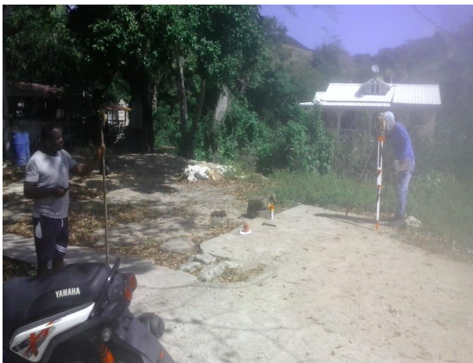
Replanteo topográfico
